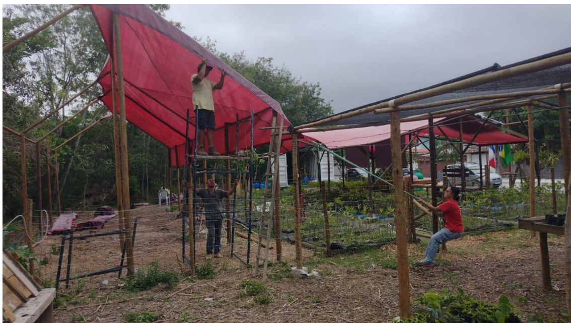
Figura 14 – Montagem da estufa de hidroponia. 14/10/2025.
